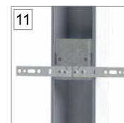
11 Elementy wzmocniające konstrukcję ościeżnicy z kotwami montażowymi
