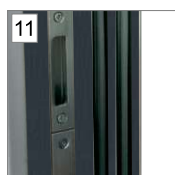
Przegroda termiczna, dwie uszczelki w ościeżnicy
