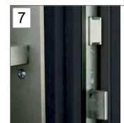
Zasuwnica GU, zamek podstawowy z blokadą klamki
