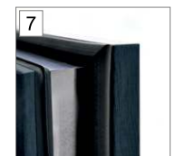
Przegroda termiczna, dwie uszczelki w skrzydle
